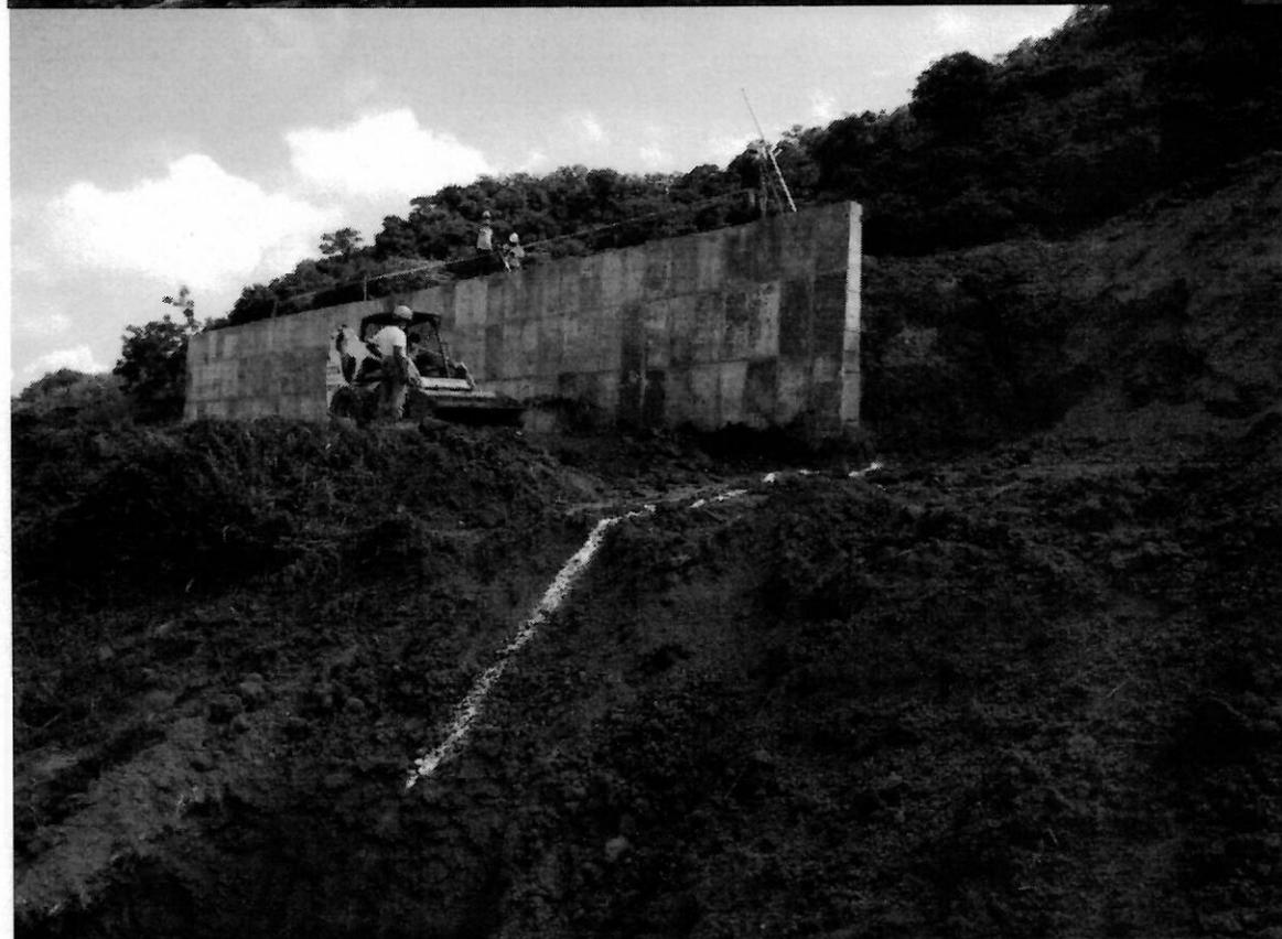
FOTO No.2 EXCAVACION MURO ESCALONADO
